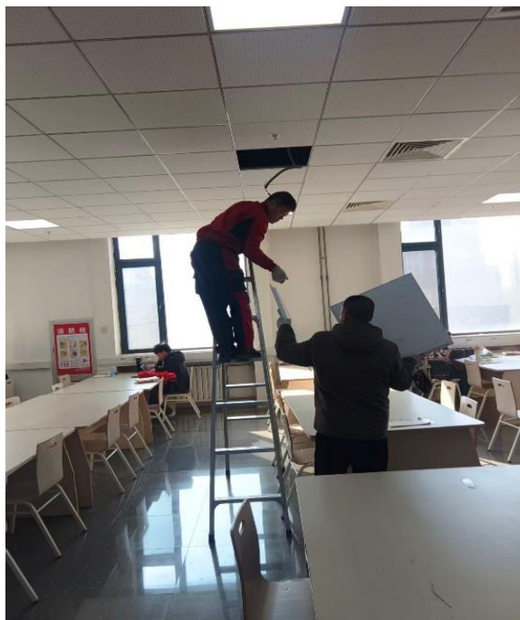
图书馆三楼照明检修
