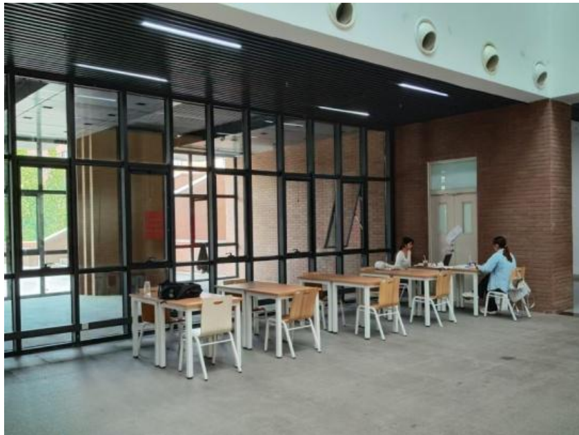
二楼共享大厅照明设备改造提升
