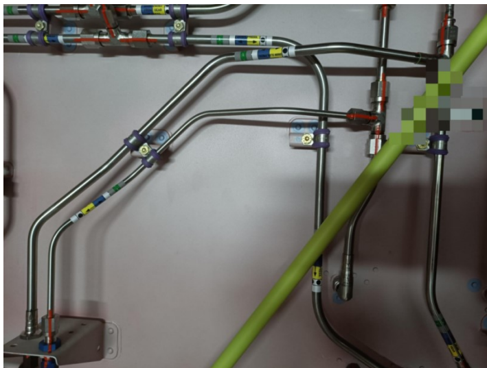
图 3-1 大中型喷气式支线客机前起落架舱门开关液压管路实物图
